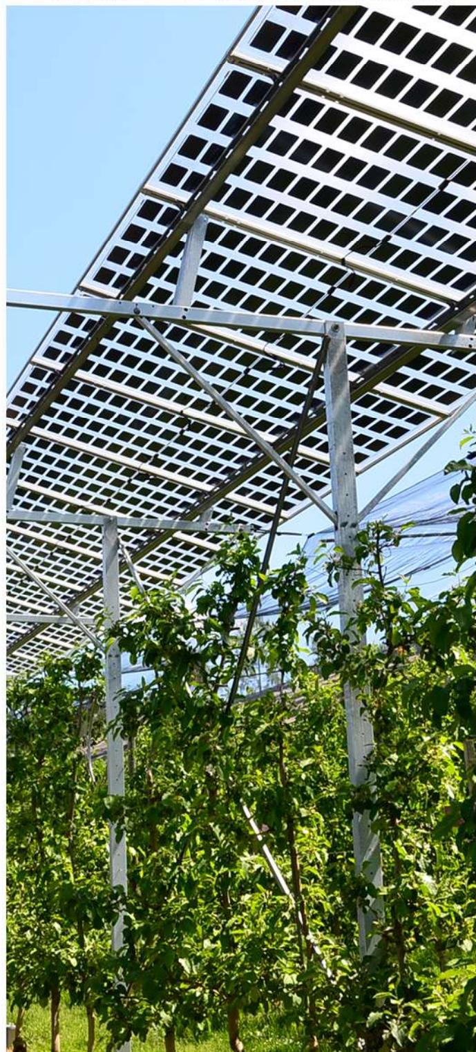
Agri-PV-Anlage Versuchsstation, Obst- und Weinbau Haidegg, Abt. 10
